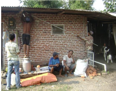
Gambar 5 : Saat instalasi pipa distribusi ke warga
