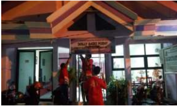
Gambar 3. Pemasangan neon box di dolli saiki point
