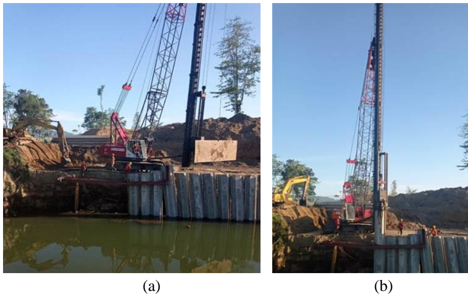
Gambar 7. (a) Pemindahan Plat Lintasan Crane, (b) Pemancangan Sumber: Dokumentasi Penulis, 2023
