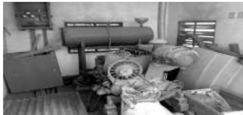
Kondisi genset dalam keadaan kurang baik, karena perlu perbaikan instalasi listrik seperti kabel listrik yang hilang dan peralatan yang berkarat pada mesin.
