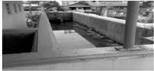
Kondisi unit penangkap lemak dan benda terapung dalam keadaan kurang baik karena belum dilakukan pemeliharaan rutin dengan pengurasan dan pembuangan limbah.
