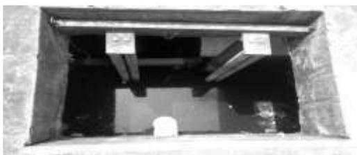
Kondisi pompa air limbah dalam keadaan kurang baik karena instalasi listriknya rusak dan belum dilakukan pemeliharaan rutin.
