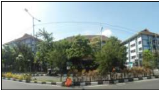
Gambar 3. Tampak depan bangunan Rusun
