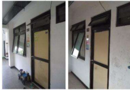
Unit tepi lantai 2
