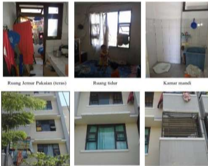
Gambar 17 Facade Rumah Susun Grudo sisi Luar
