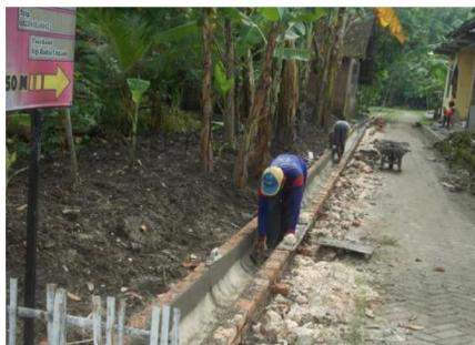
Gambar 1. Perbaikan Saluran Drainase
