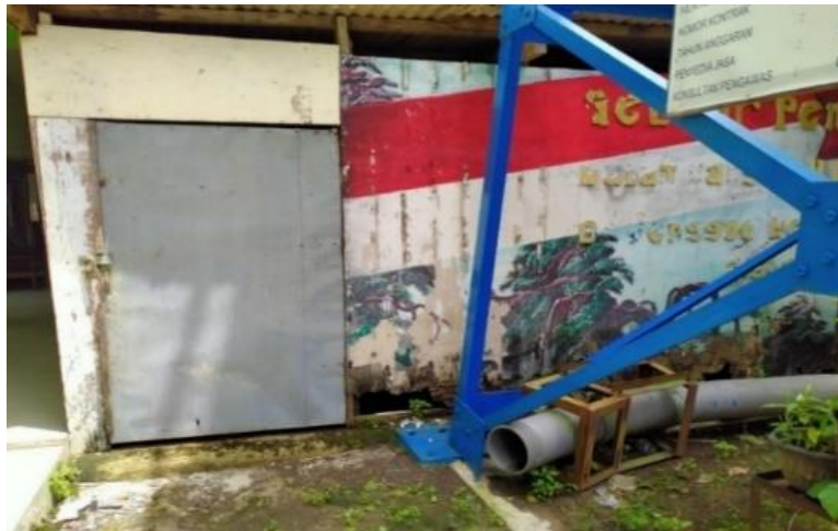
Gambar 2. Gudang Penyimpanan Pupuk di Desa Jenggot (Sumber : Data Diolah Oleh Penulis, 2022)
