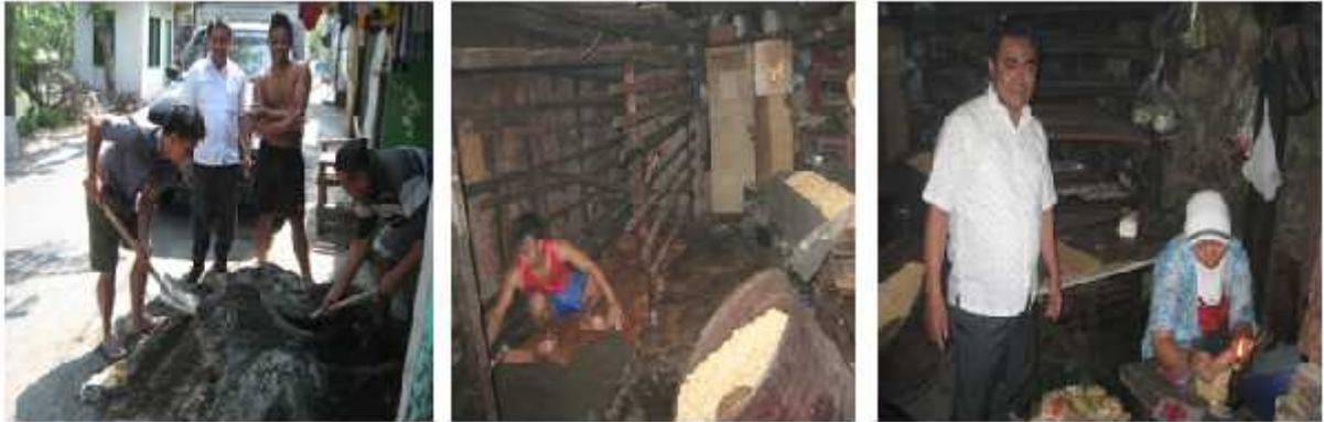
Gambar 3 Realisasi Rabat lantai perbaikan lantai tempat Produksi
