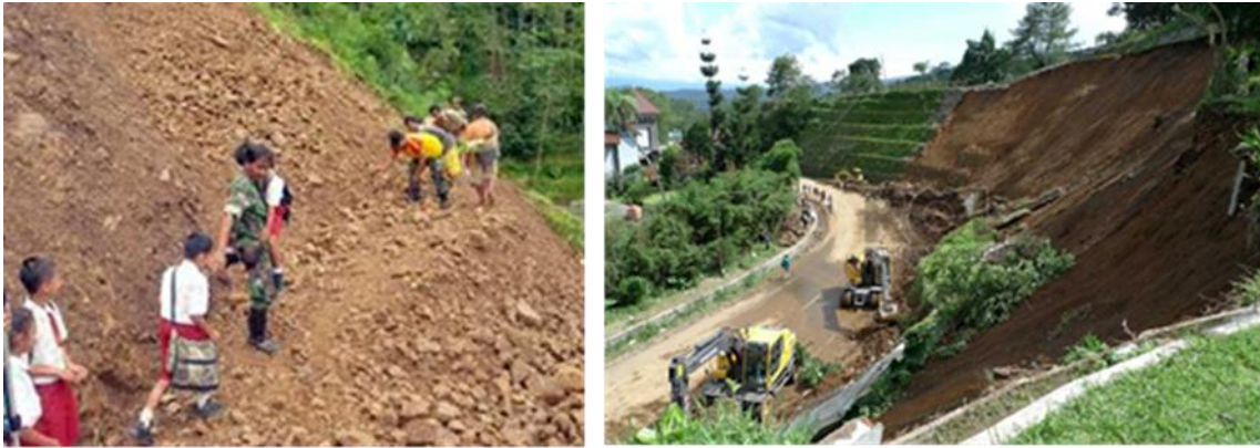
Gambar 4. Tanah longsor dangkal merusak beberapa jaringan transportasi
