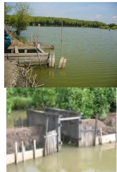
Gambar 7. Pintu air model Monik sebagai pintu utama pemasukan air sekaligus pengeluaran air tambak
