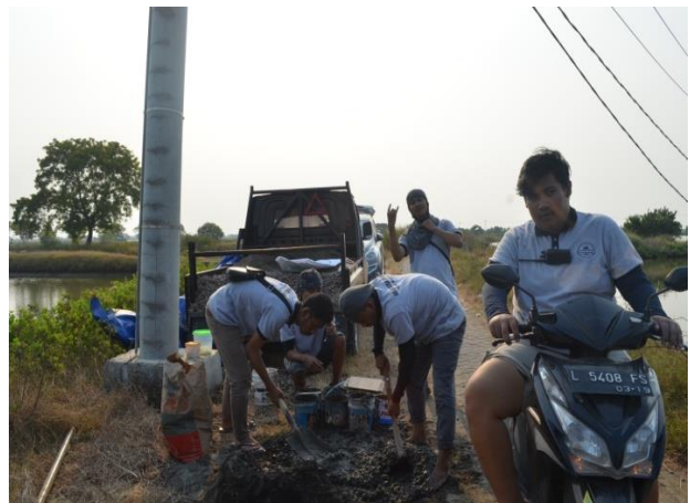
Gambar 2 Pembangunan Pondasi Tiang Lampu
