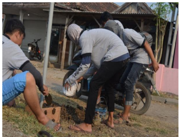
Gambar 3 Pengecoran Pondasi Tiang Lampu
