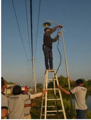
Gambar 4 Penyambungan dan Pemasangan Lampu Jalan
