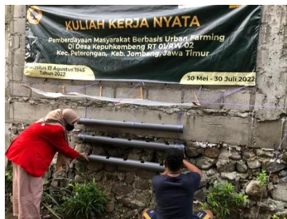
Gambar 3.3 pemasangan rak pipa
