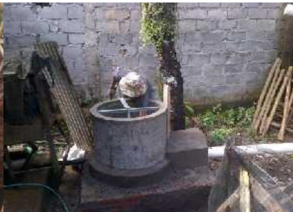
Gambar 4 : Saat merapikan kubah reaktor
