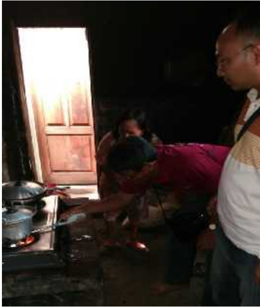
Gambar 5 : Saat instalasi pipa distribusi ke warga
