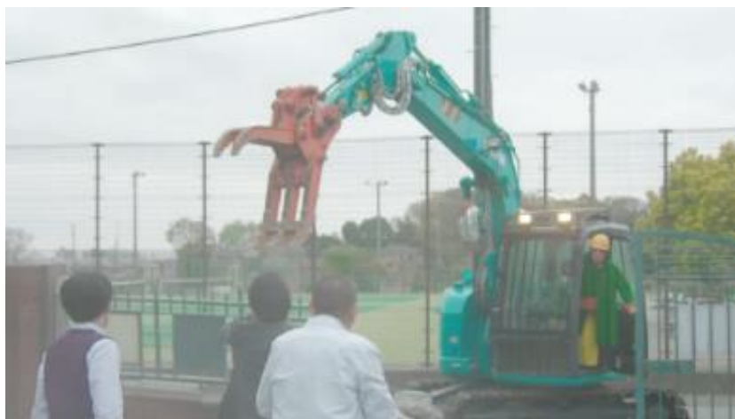
Gambar 2. Upaya Harada untuk Merobohkan Pagar Menggunakan Excavator Sumber: Kariyama & Katō (2019), Eps. 1 (45:03) ©Nippon TV
