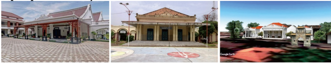
Gambar 8. Bangunan Lama di Kota Pasuruan (Sumber: dokumentasi penulis)
