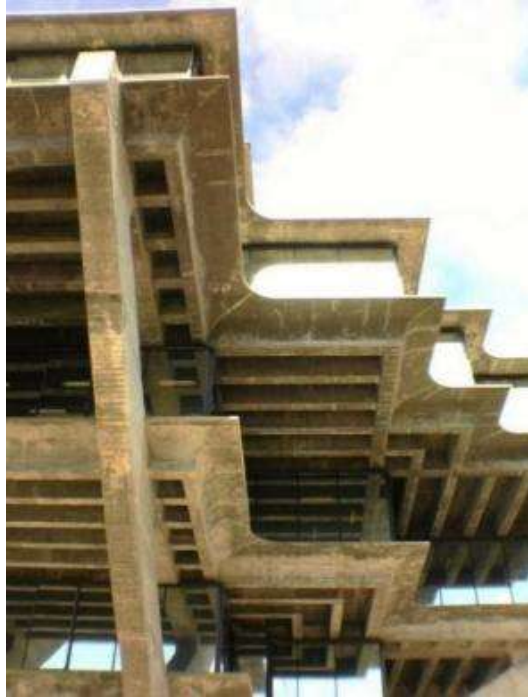
Gambar 6. Penampakan balok pada bawah gedung utama (sumber : archdaily.com, 2022)
