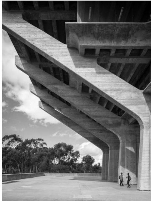
Gambar 2. Penampakan struktur balok Geisel Library (sumber : archdaily.com, 2022)
