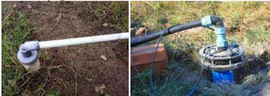
Gambar 9. Sumur Bor Menggunakan Pompa Celup (Rolisasi dkk, 2021)
